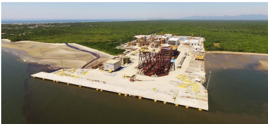
Figura 7 – Construção do Porto em Pontal do Paraná-PR.
